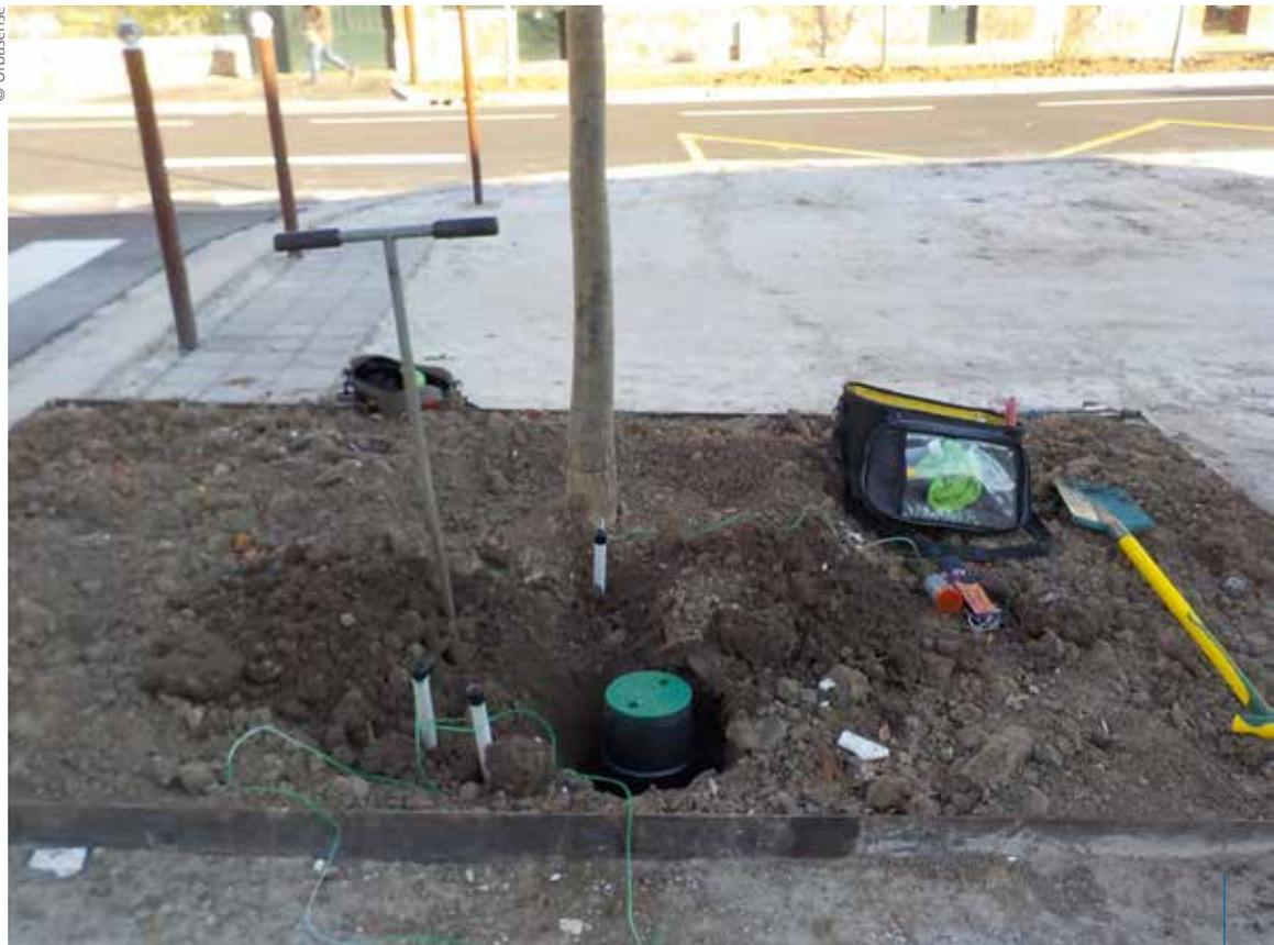
Les sondes sont placées à différentes profondeurs dans le sol pour déterminer les quantités exactes d'eau à apporter au plus près des racines.
